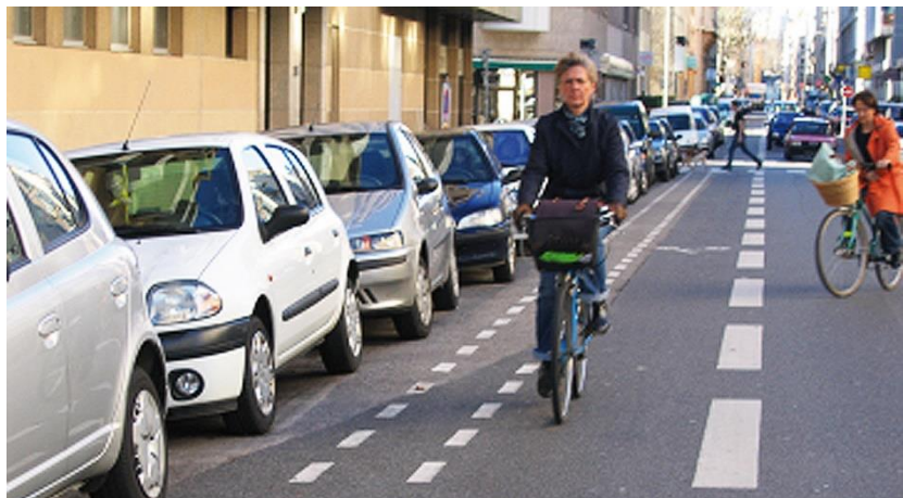
Bande cyclable avec espace tampon de 0,5 m
